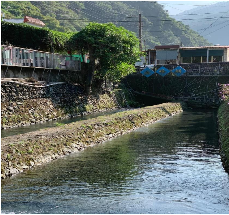
引水工程隧道出口
