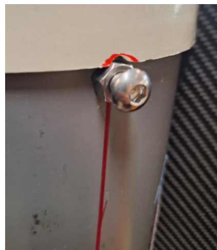
底座使用3支膨脹螺絲固定端點
